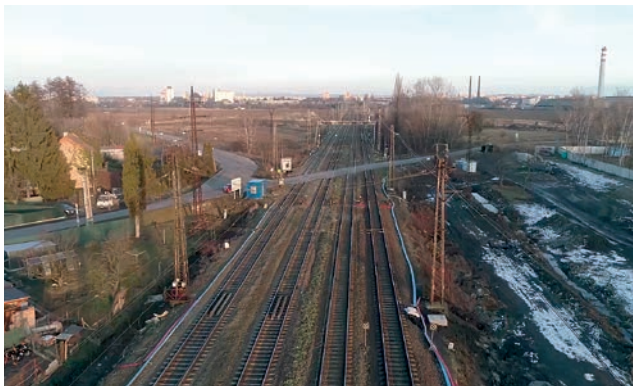
Stávající v budoucnu zrušený přejezd Dluhonice
